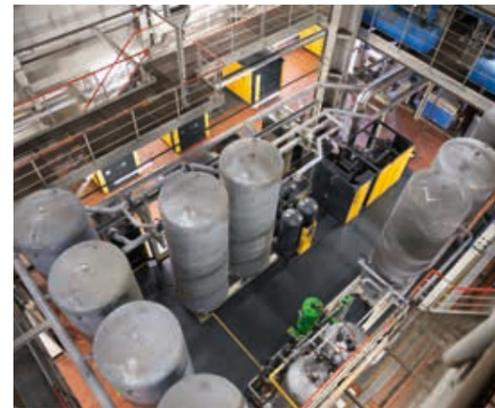
Zwei unterschiedliche Druckluftaufbereitungssysteme trocknen die Druckluft für den jeweiligen Bedarf.
