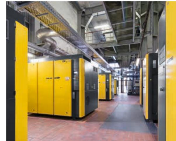
In der Druckluftstation arbeiten insgesamt vier Schraubenkompressoren mit dem energiesparenden SIGMA PROFIL und IE4-Antriebsmotoren.
