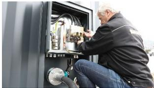
Dank „Quick Connect“, einem leicht zu bedienenden Anschlussboard für Rohre und Kabel, kann er schnell und quasi an nahezu jedem Ort in Betrieb genommen werden.
