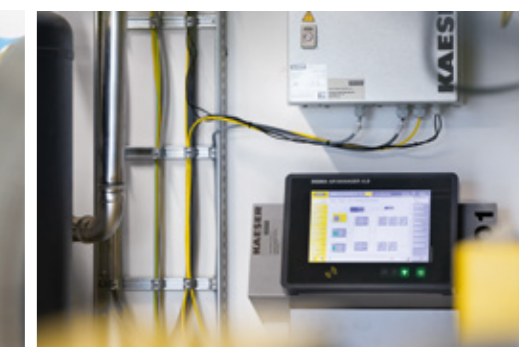
Foto links: Flussmittel gehören zum Produktportfolio des weltweit führenden Herstellers. Foto Mitte: Das vorbereitete Rohmaterial wird in mehreren Schritten zu den kundenspezifischen Produkten weiterverarbeitet. Foto rechts: Dank des SIGMA AIR MANAGERS 4.0 hat der Betreiber alle Betriebsdaten jederzeit im Blick. Foto unten: Dank SIGMA AIR UTILITY zahlt BRAZETEC einfach nur die Druckluft, die tatsächlich gebraucht wird.
