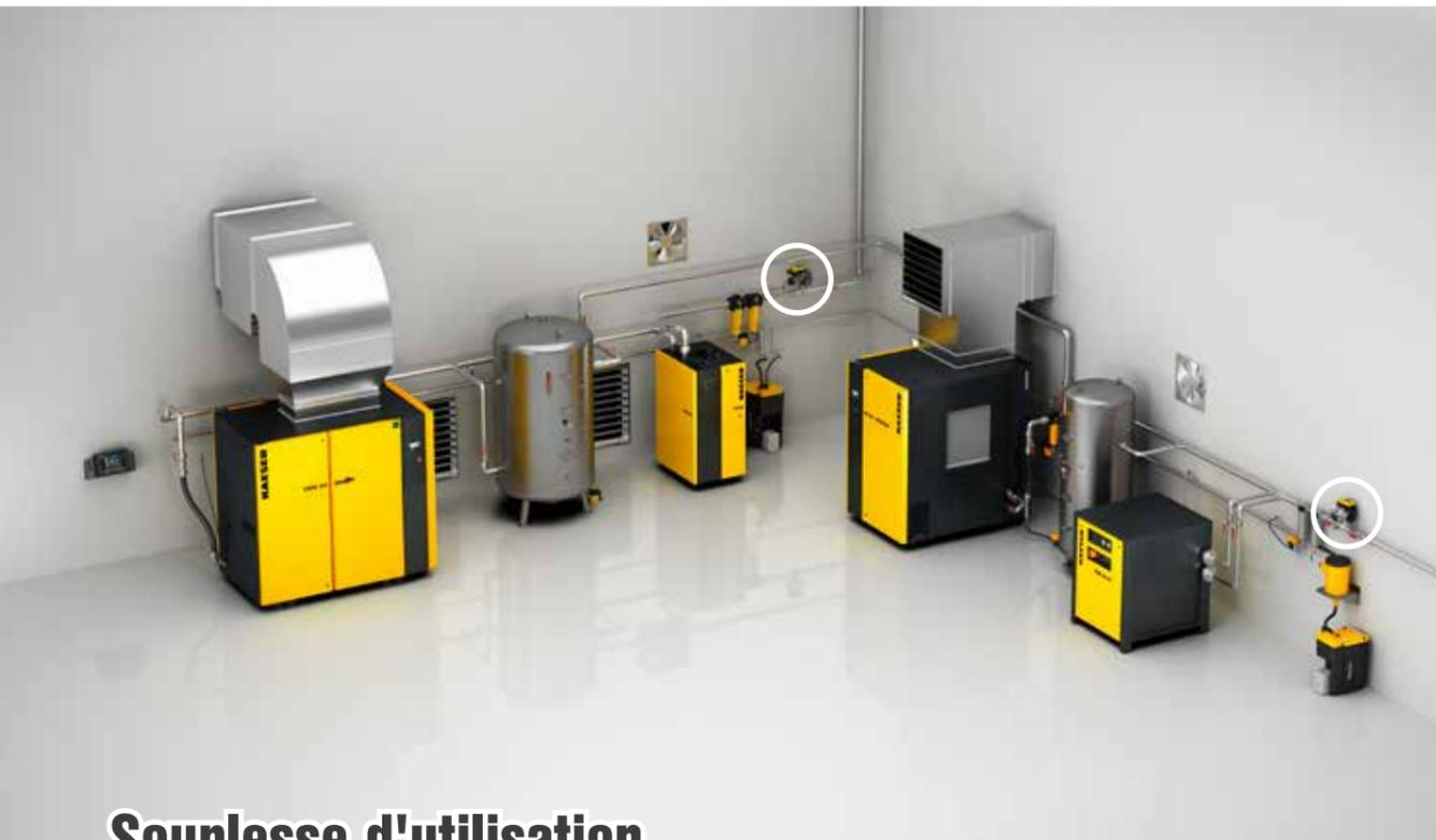
Fig. : Exemple de station d'air comprimé
